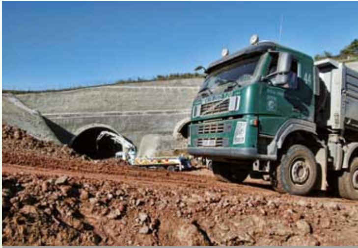
VÝSTAVBA PRAŽSKÉHO PORTÁLU TUNELU PRACKOVICE
